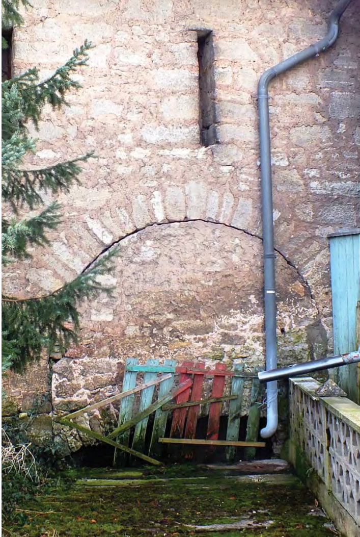
Abb. 8: Gemauerte Reste des sogenannten Backsgrabens .
