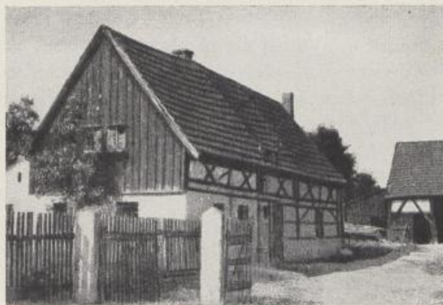
Bild 80: Massiv untermauertes Umgebindehaus mit Drempel in Deutschbaselitz, Kreis Kamenz, Nr. 17 a
