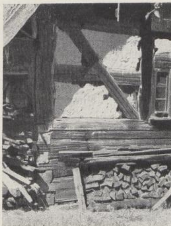
Bild 81: Wechsel von Blockbau- und Fachwerktechnik in einem Geschoß in Reichwalde-Schäferei, Kreis Weißwasser, Nr. 83
