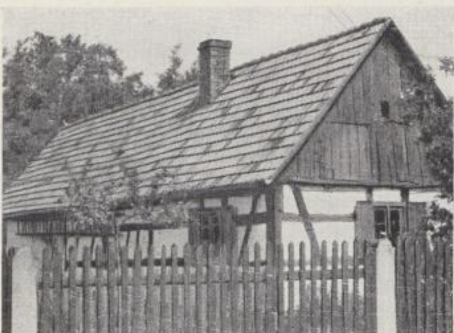
Bild 74: Eingeschossiges Fachwerkhaus in Schadendorf, Kreis Weißwasser
