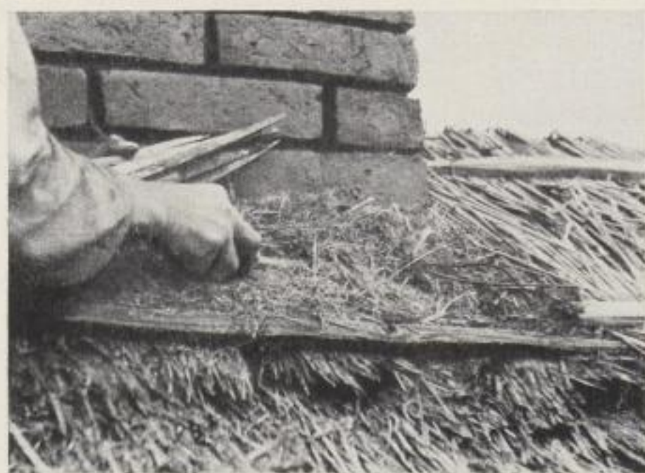
Bild 109: Fugendichtung mit Hanf
