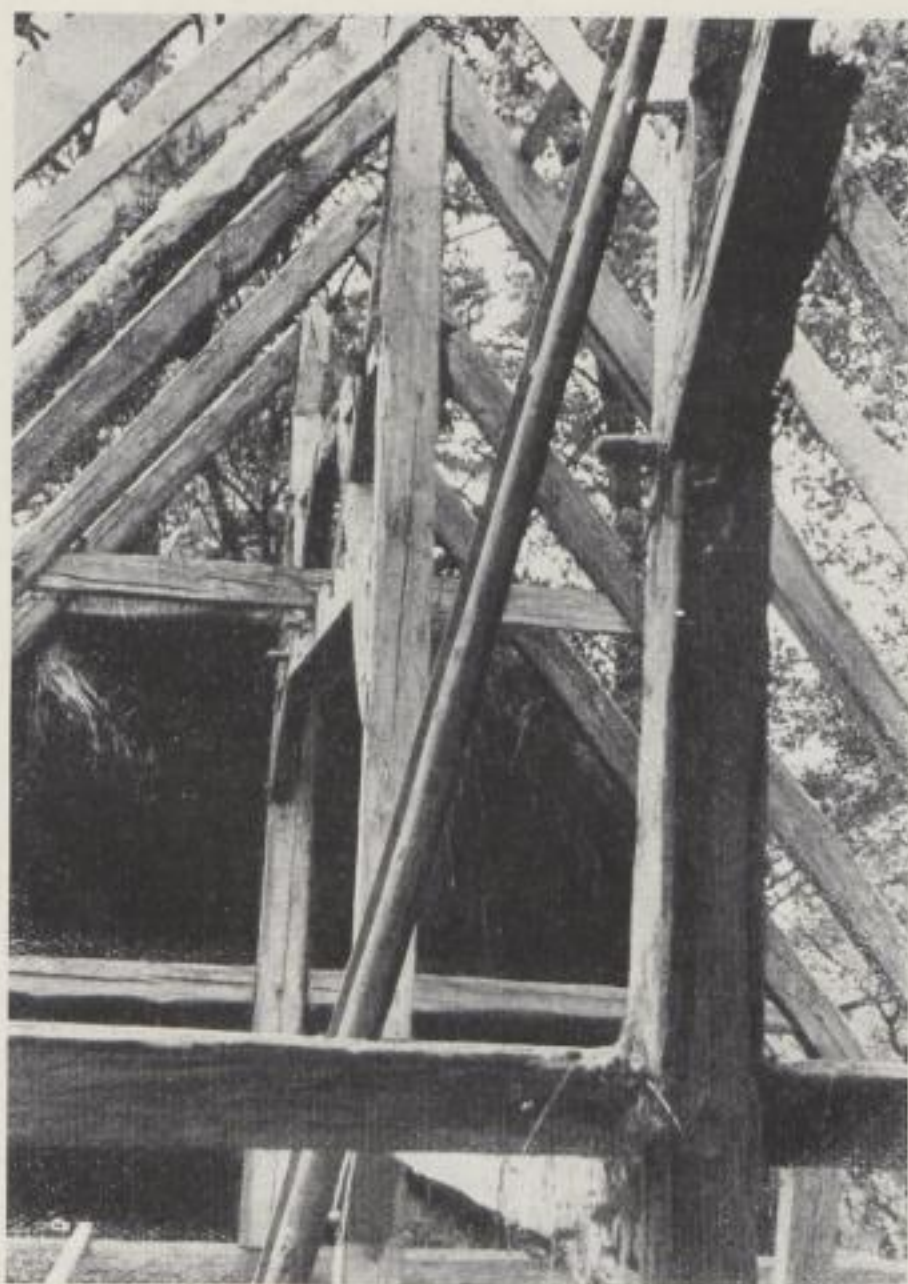
Bild 91: Einfach stehender Stuhl mit Firstsäulen und Längsverband mit „Doppelreitern“ in Burg/Spreewald Nr. 222
