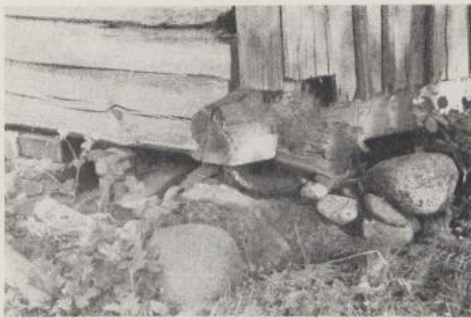
Bild 59: Eckauflagerung der Blockwand auf einem Feldsteinfundament in Burg-Kolonie Nr. 155
