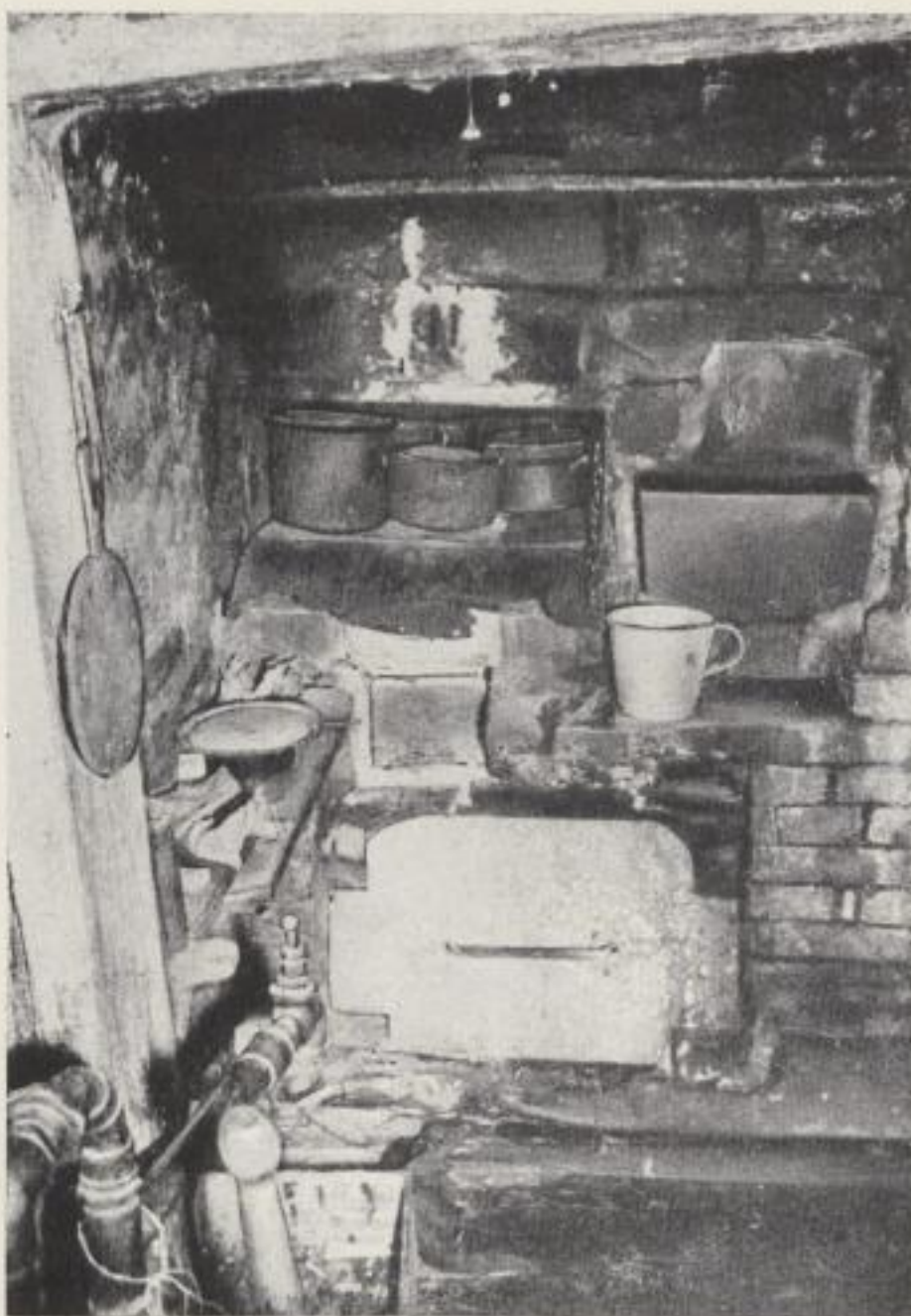
Bild 125: Blick durch ein Vorgelege auf die Feuerwand. Unten die mit Blechdeckel verschlossene Backofenmündung. Darüber Feuerung, Kochröhre und Wasserpfannen des Stubenofens. Alte Schmiede in Commerau bei Klix, Kreis Bautzen
