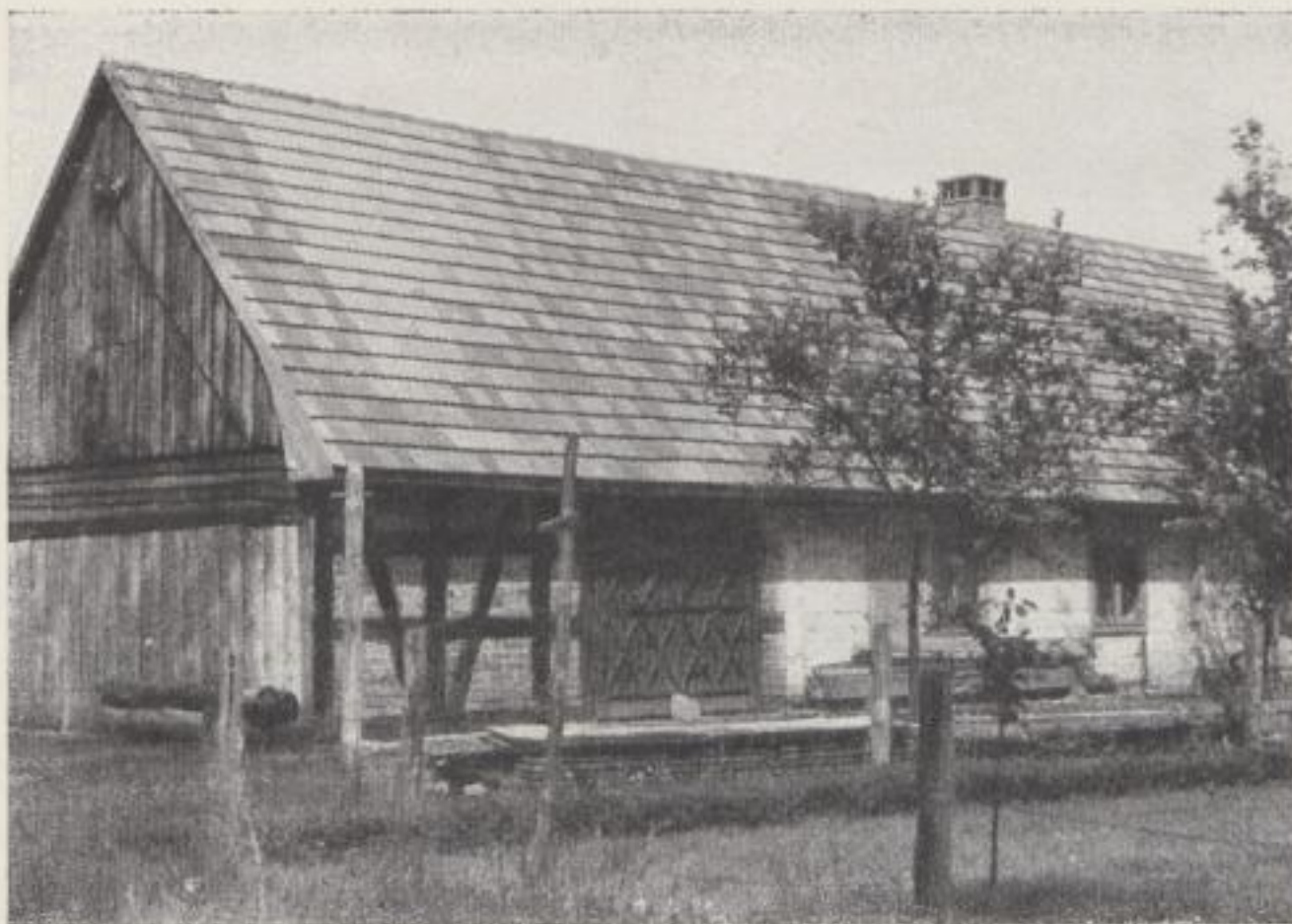
Bild 160: Der hintere Gebäudeteil wurde abgerissen
