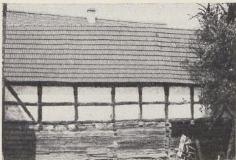
Bild 79: Stallgebäude in erdgeschossigem Blockbau mit Fachwerkobergeschoß in Saalau, Krs. Hoyerswerda, Nr. 11
