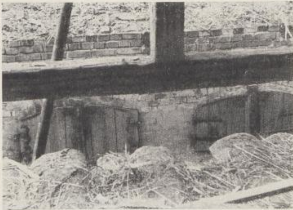
Bild 58: Futterklappen im Wohnstallhaus Burg/Spreewald Nr. 222
