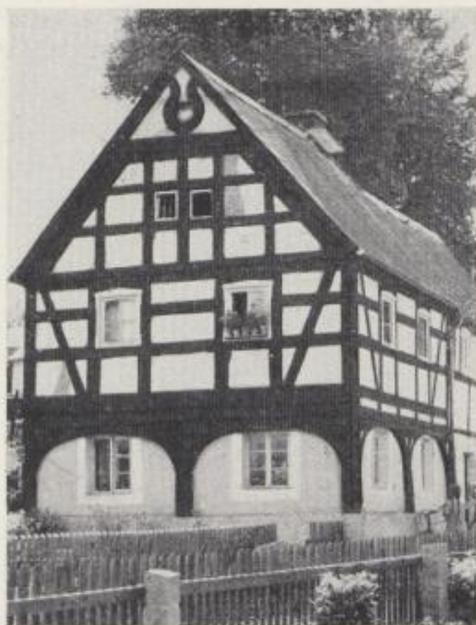
Bild 75: Erdgeschossiges Umgebände des Wohnteils mit Fachwerkobergeschoß. Die Blockstube ist bereits durch Mauerwerk ersetzt worden. Crostwitz, Kreis Kamenz
