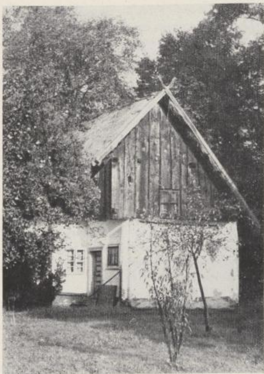
Bild 94: Giebellaube in Burg/Spreewald Nr. 222
