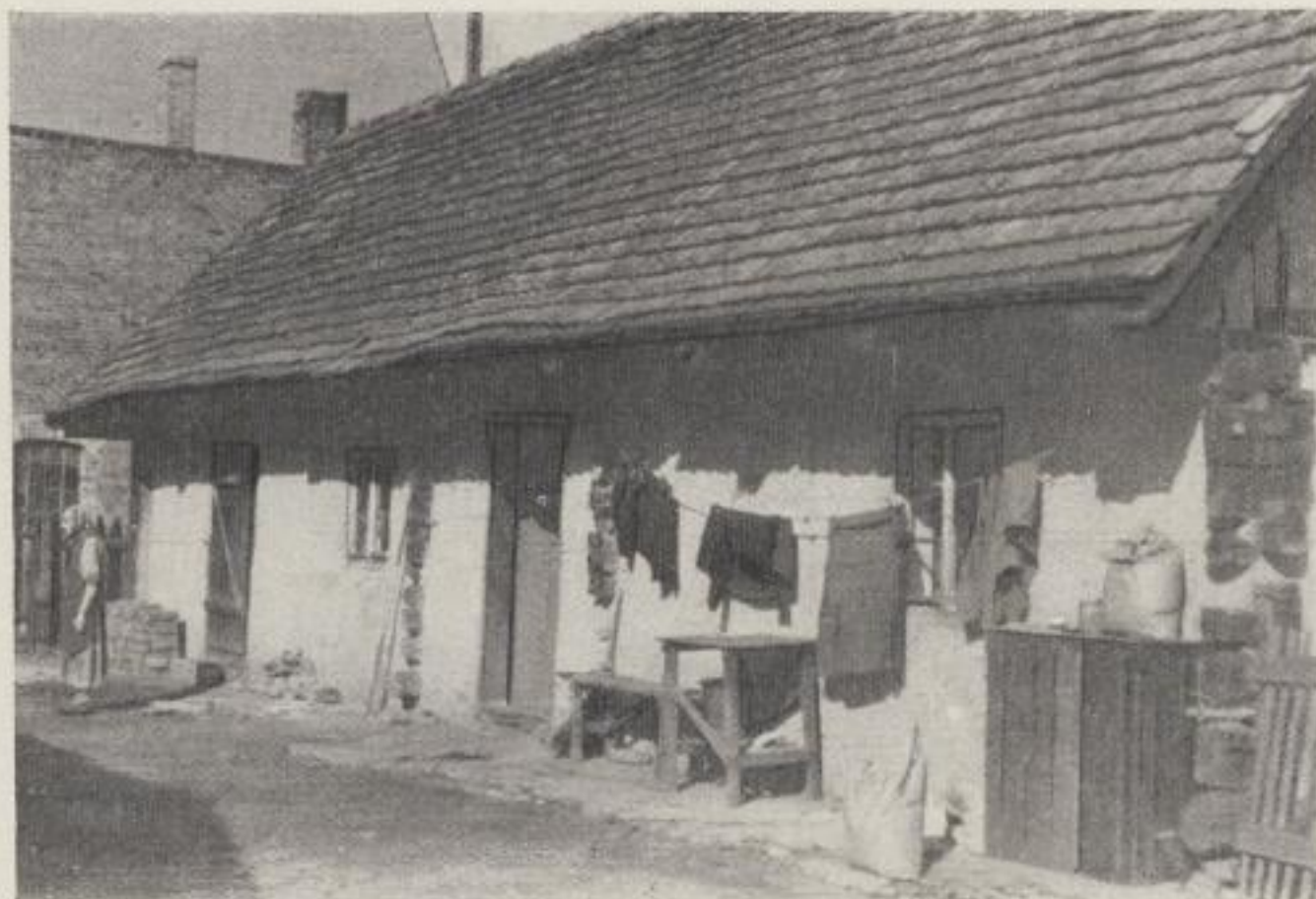
Bild 60: Blockhaus mit Lehmverputz in Weißwasser Nr. 103
