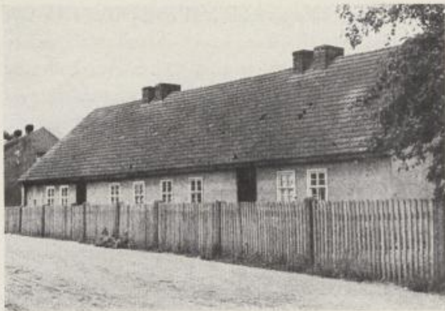
Bild 130: Doppelwohnhaus mit zwei „schwarzen Küchen“ und vier Wohnungen in Byhlegure, Kreis Lübben, Nr. 51
