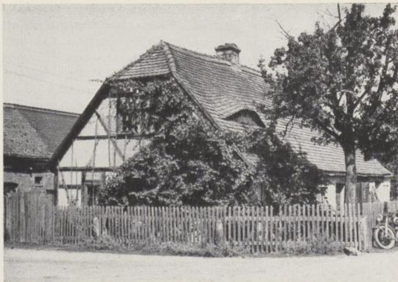
Bild 76: Dorfschmiede mit Fachwerk und Krüppelwalm in Come- rau bei Klix, Kreis Bautzen
