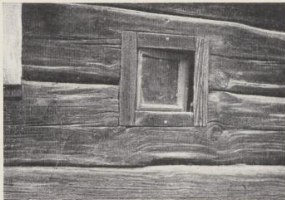
Bild 133: Einflügeliges Drehflügel Fenster, Bukonica bei Sagar, Kreis Weißwasser
