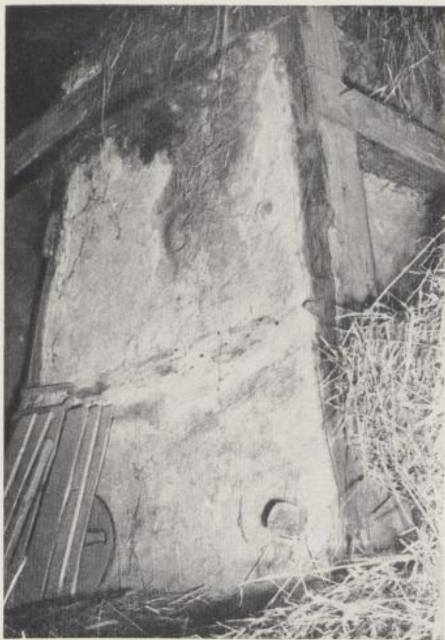
Bild 127: Balkengerüst eines Rauchschlotes. Uhyst / Spree, Bahnhofstraße
