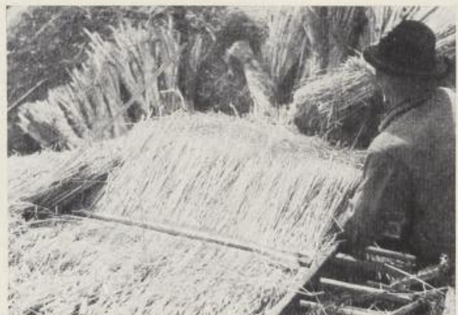
Bild 102: Befestigen der Bandruten
