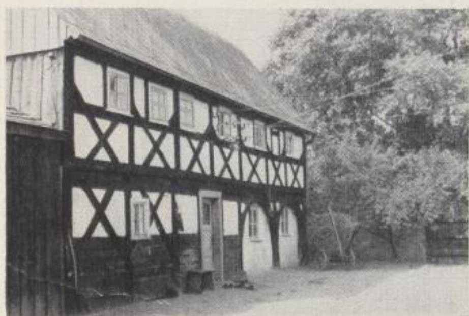
Bild 70: Erdgeschossiges Umgebände der Wohnstube mit Fachwerk im Wirtschaftsteil und Obergeschoß, Laske, Kreis Kamenz, Nr. 6
