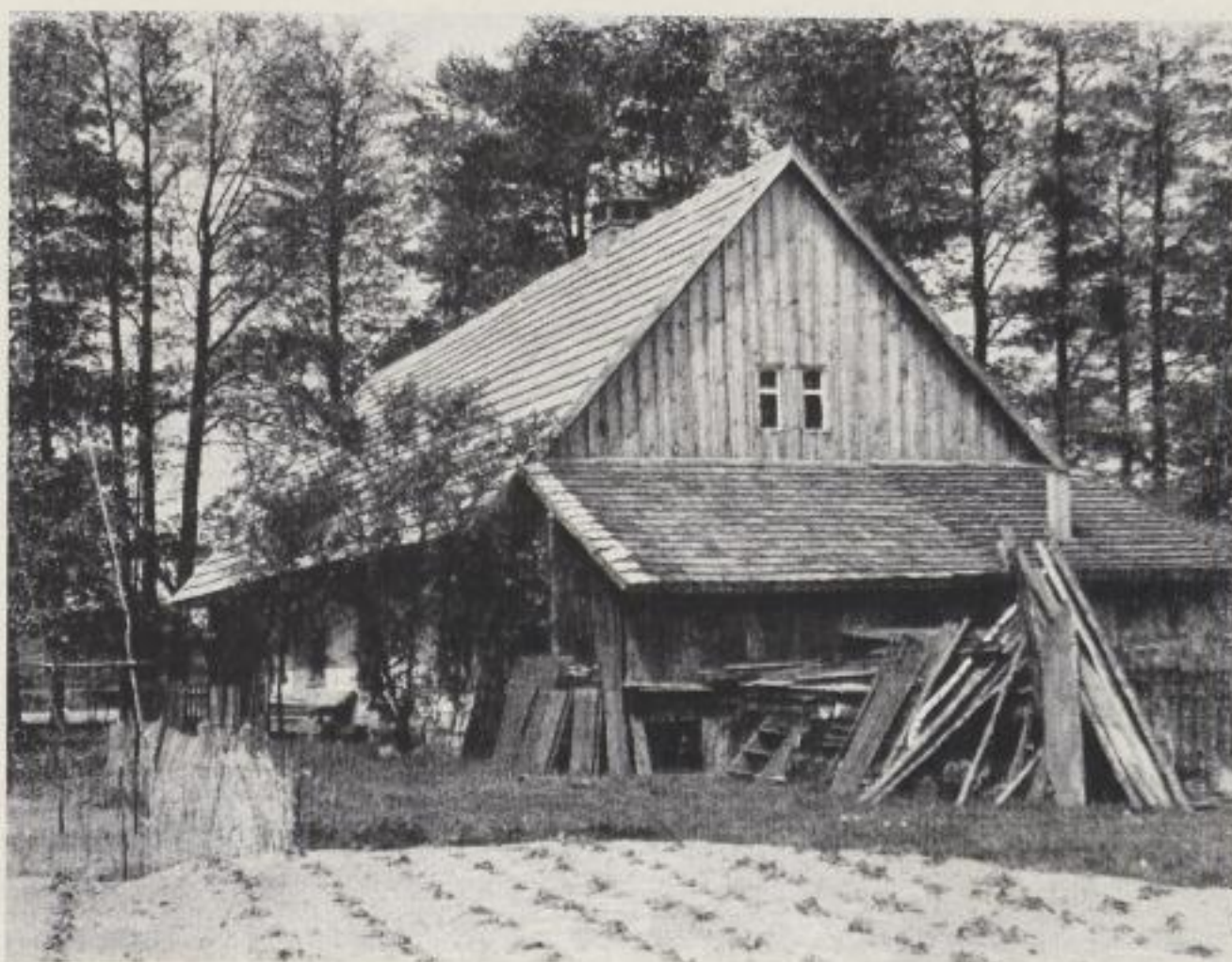
Bild 159: Wohnstallhaus Burg-Kolonie Nr. 246 nach dem Umbau. Die alte Giebellaube wurde durch einen Schuppen ersetzt
