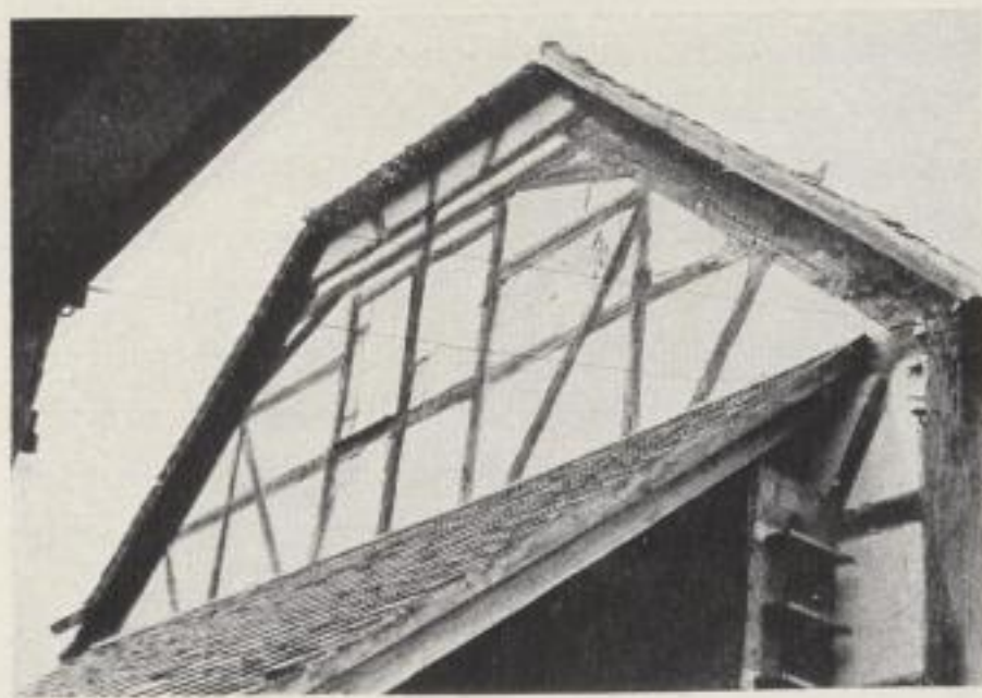
Bild 95: Liegender Dachstuhl mit Krüppelwalm eines Wohnstallhauses in Zschornau, Kreis Kamenz, Nr. 33
