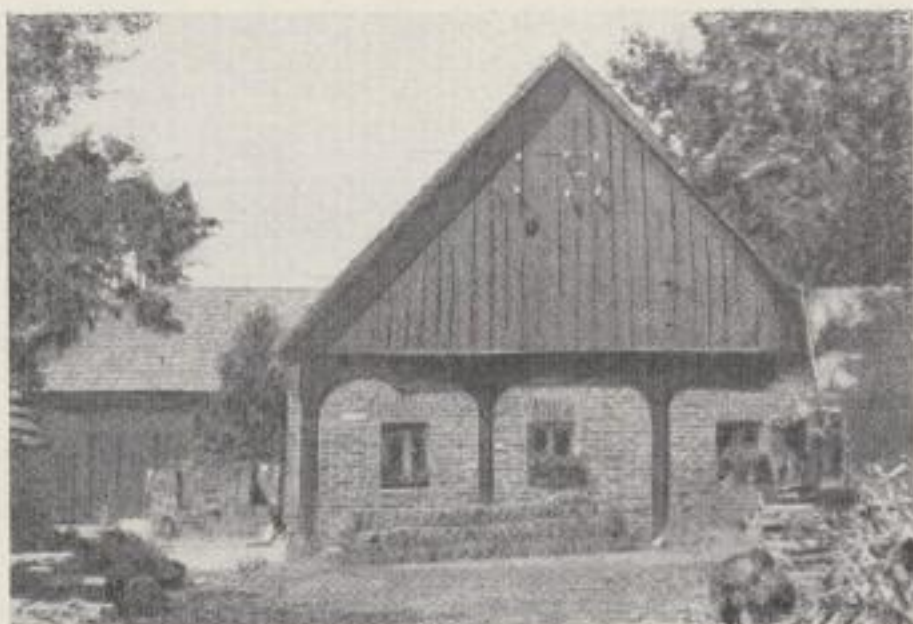
Bild 67: Ausgemauertes Giebelumgebinde in Kringelsdorf, Kreis Hoyerswerda, Nr. 4
