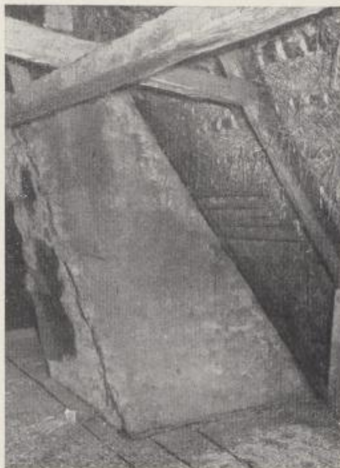
Bild 128: Rauchschlot aus Lehmstakwerk. Klein-Partwitz, Kreis Hoyerswerda, Nr. 11
