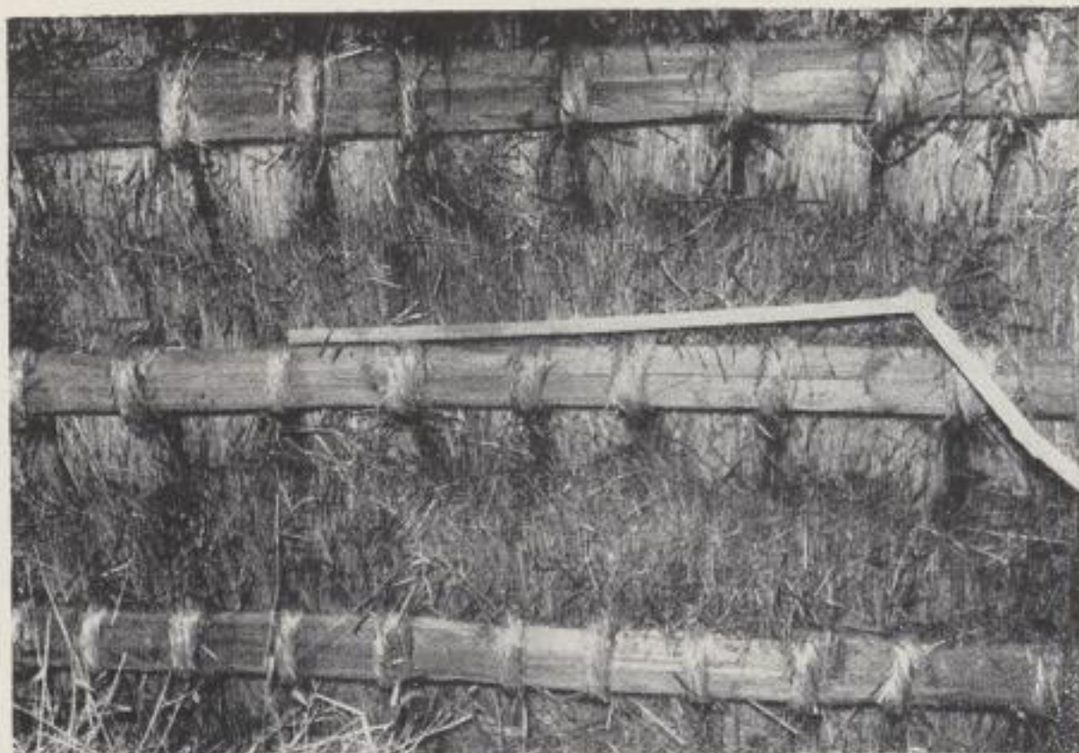
Bild 97: Strohdach mit einzeln befestigten Schauben in Klein-Partwitz, Kreis Hoyerswerda
