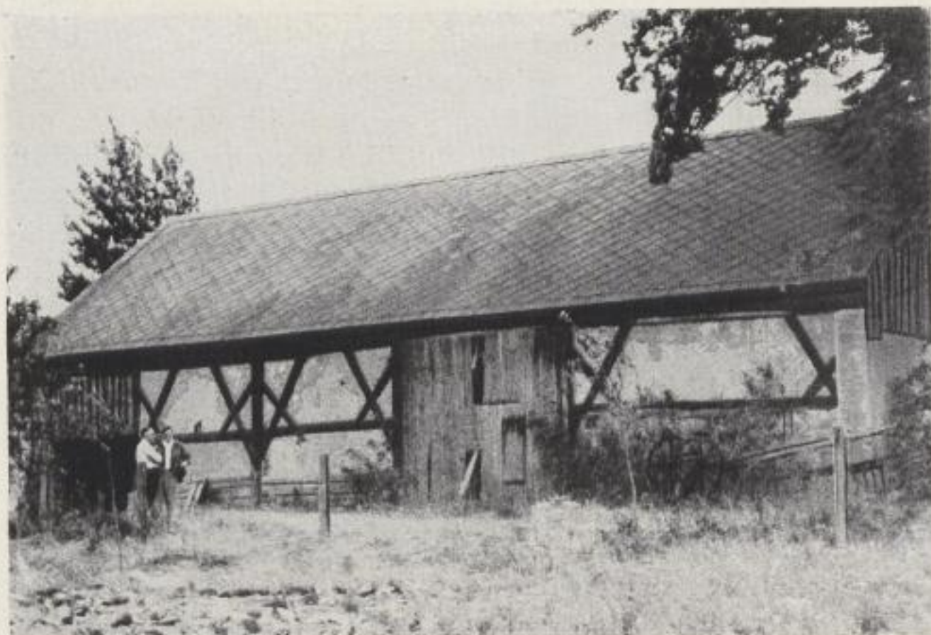
Bild 72: Ständerkonstruktion an einer Scheune in Crostwitz, Kreis Kamenz
