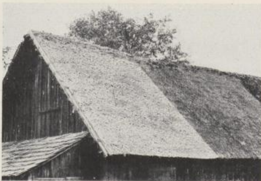
Bild 107: Nachdunkeln des Strohdaches
