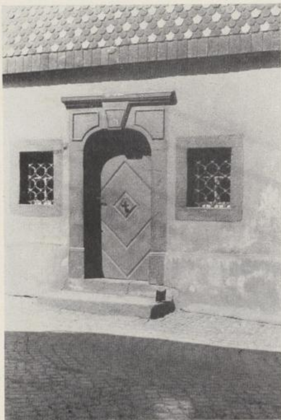
Bild 148: Der typische Hauseingang des Lausitzer Umgebäudehauses. Haustür mit beiderseitigen Flurfenstern in Obereunnersdorf
