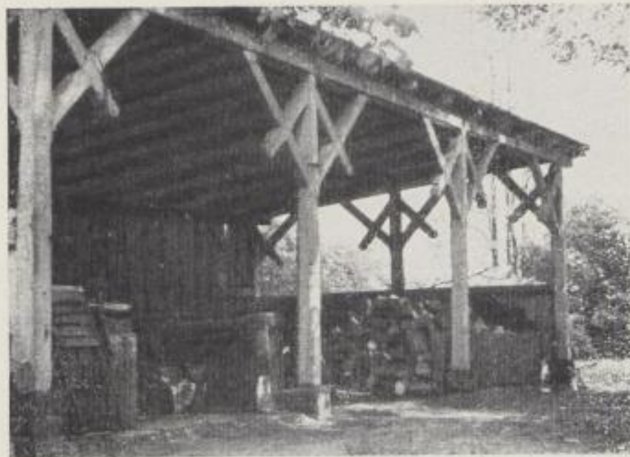
Bild 96: Fortleben der alten Reiterkonstruktion des Dachlängsverbandes bei einem Schuppenbau der „Bleiche“ in Burg-Kolonie
