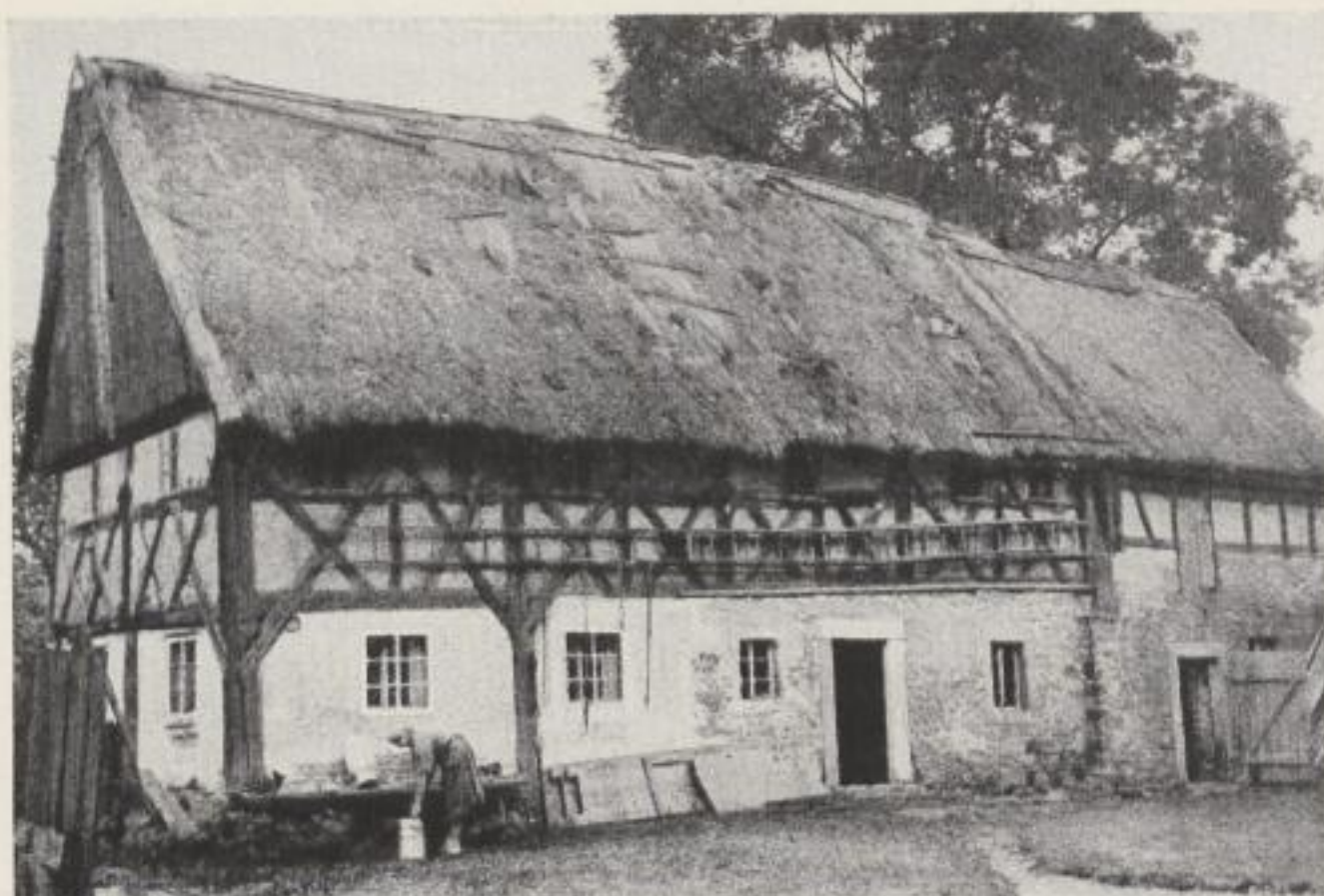
Bild 71: Zweigeschossiger Ständerbau mit ausgemauertem Erdgeschoß in Soritz, Kreis Bautzen
