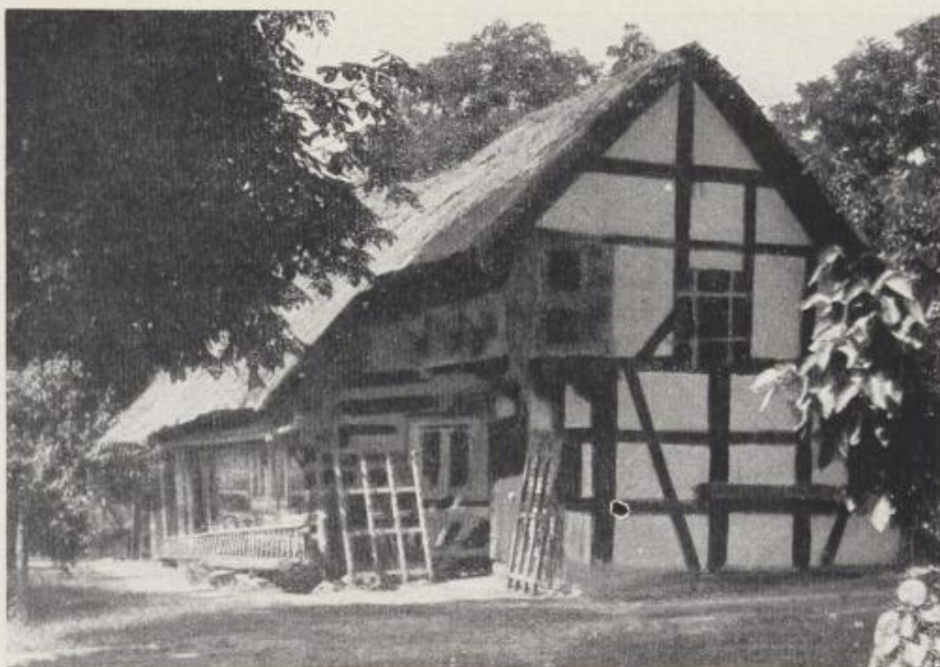
Bild 26: Fachwerk-Giebelkammer an einem Blockhaus in Burg
